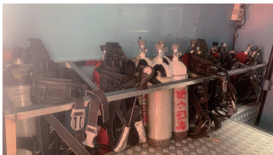
圖 1、巧思設計空氣呼吸器置放架，提升氣瓶存量及取用便利性
